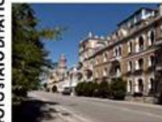
FOTO STATO DI FATTO
